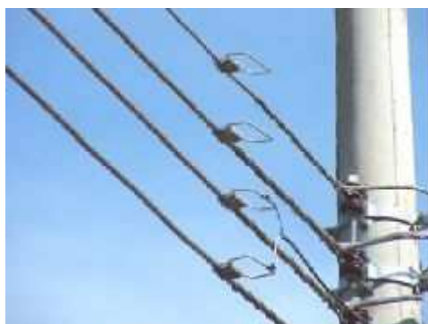
Figura 01 – Estribo com conector cunha
